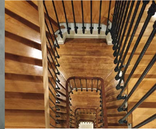
> Reproduction à l'identique dans un immeuble haussmannien de deux escaliers
